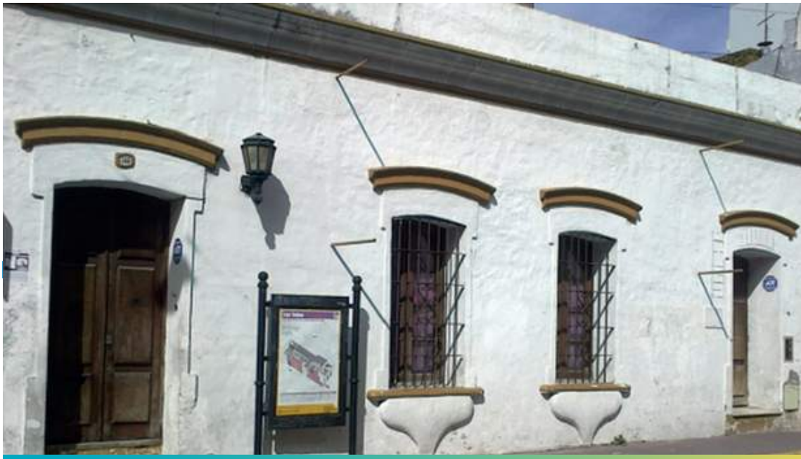
Fachada del inmueble situado en la calle Defensa al 1300, Ciudad Autónoma de Buenos Aires.
