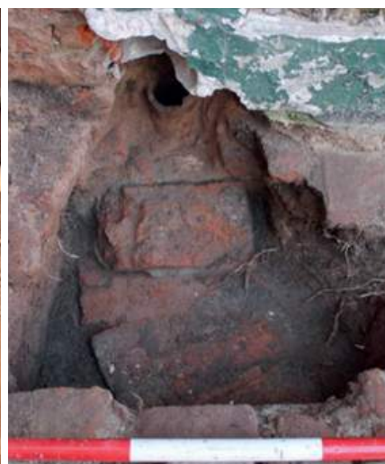
Desagüe de hierro como bajada pluvial que se conecta con los desagües horizontales de ladrillo
